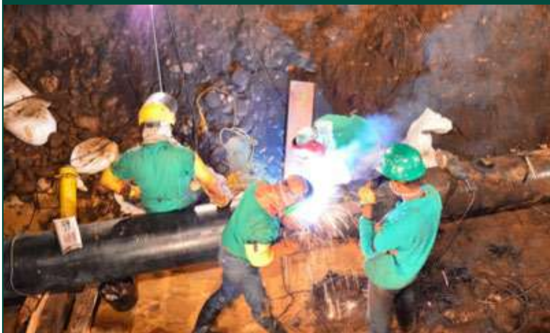
Reparación de oleoductos
