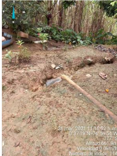
Fotografía 0-7 Tubería de descarga Predio Vías del socorro Coordenada Datum Magna Sirgas Origen Nacional: E4546990 N1617494
